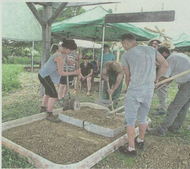
Préparation pour la construction d'un mur en pisé.
