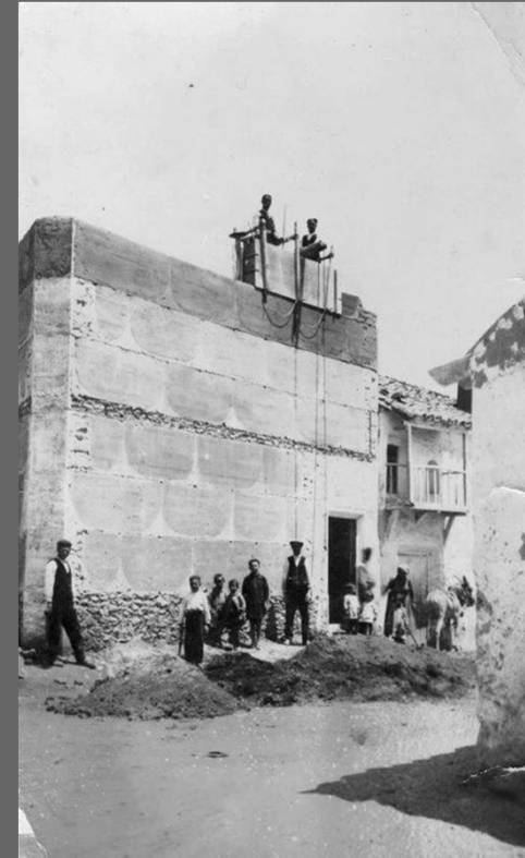
GANG OF BRINKLAYERS STEPPING ON EARTH WALL IN ARGAMASA DE ALBA (CIUDAD REAL. ESPAÑA) 1930s
