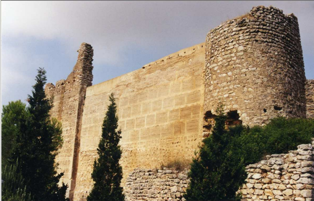
CASTILLO DE XIVERT. SU ORIGEN ES MUSULÁN Y BUENA PARTE DE SUS MUROS SON DE TAPIAL.
