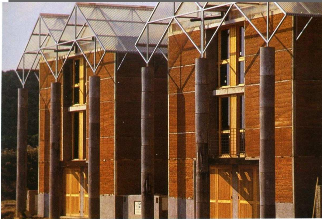
EDIFICACION DE TAPIAL CERCA DE GRENoble (FRANCIA). PROYECTO DE LOS AÑOS 80 EN EL QUE SE CONSTRUYERON 64 UNIDADES HABITACIONALES CONSTRUIDAS CON DIFERENTES TIPOS DE TÉCNICAS CONSTRUCTIVAS CON TIERRA. FUENTE: ARCHITECTURES DE TERRE
