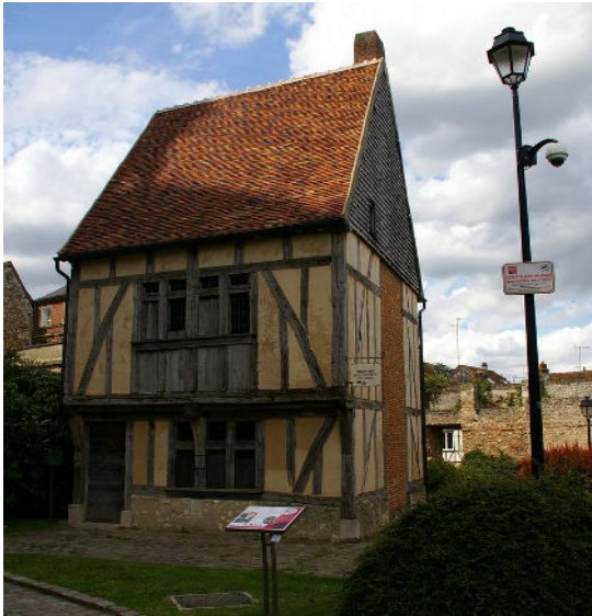
Relleno con cal y cáñamo
