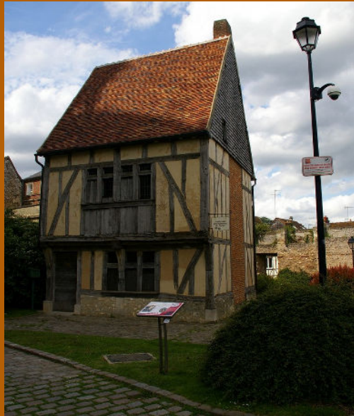
Remplir de chaux de chanvre
